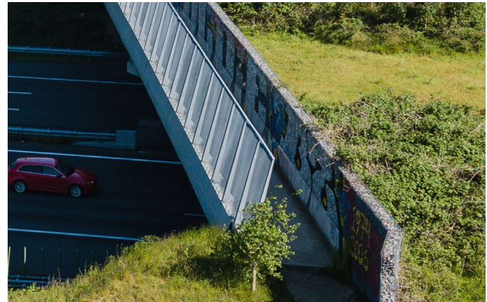
HET VOETPAD OVER HET ECODUCT, MET AAN DE LINKERKANT EEN MUUR MET DOORKIJKJES OM OVER HET ECODUCT TE KUNNEN KIJKEN
